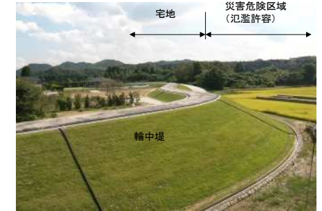
輪中堤整備状況(司野地区)
