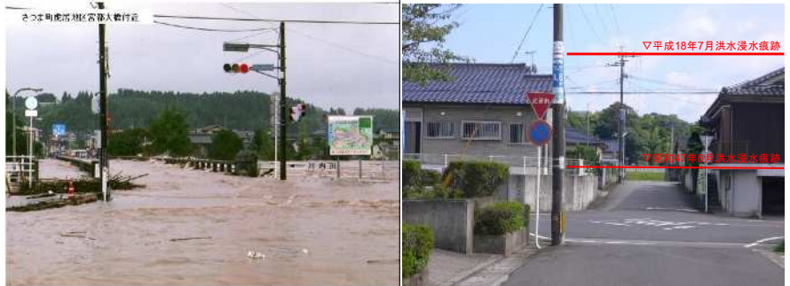
さつま町虎居(川内川右岸37k900宮都大橋)
